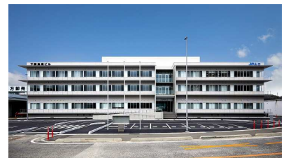
下関漁港地方卸売市場 本館中央棟機械設備工事
