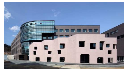
山口県立大学3号館 機械設備工事
